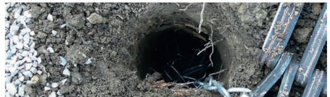
Pequeño orificio en el suelo para cadenas de anclaje + base de punto (ca. Ø 5.00 cm)
