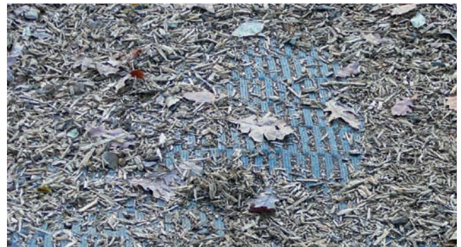
Alfombras protectoras de césped después de la instalación (abierto para la foto)
